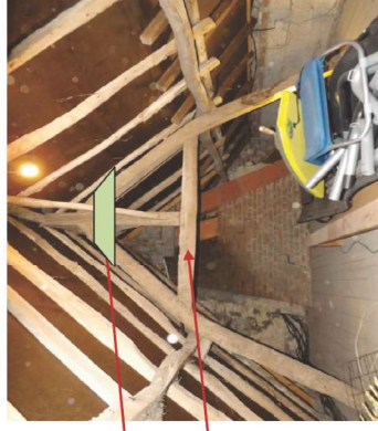
Poser un nouvel entrain, retroussé à ce niveau
