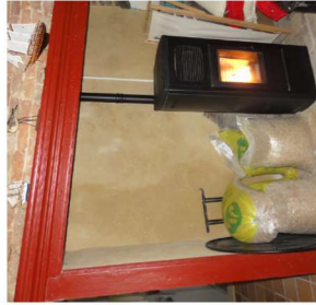
Poêle à granulés de bois de 11kW.
