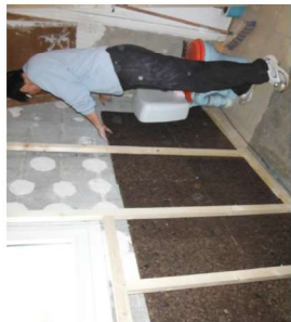
Pose du liège en partie basse du pignon, le 29 juillet 2016.
