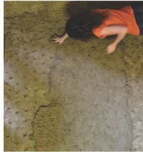
Pose de la première couche d'enduit en septembre 2016.
