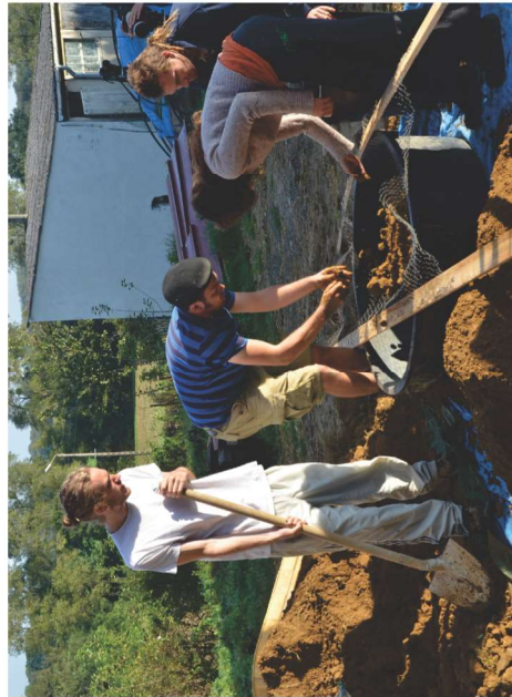
Le stage participatif : durant une journée, le chantier a été ouvert à des particuliers bénévoles désireux d'apprendre des techniques écologiques de rénovation. Encadrés par l'artisan, Hervé Bodard, ils ont pu découvrir et mettre en pratique l'enduit à caractère isolant terre-ans de lin dans une ambiance conviviale.
