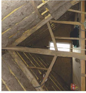
La laine de mouton va être recouverte de canisses de roseaux en duits.
