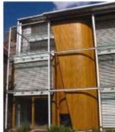
Gaine d'insufflation Puits thermiques activés d'air neuf tempéré
