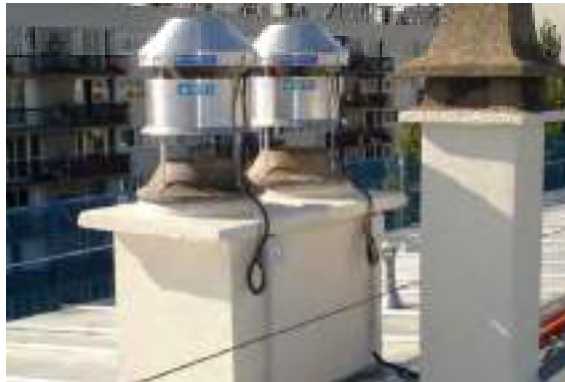
Moteur thermique naturel de l'extraction de l'air vicié. Ventilation naturelle hybride, activée ou assistée et récupérateur thermique des calories.
