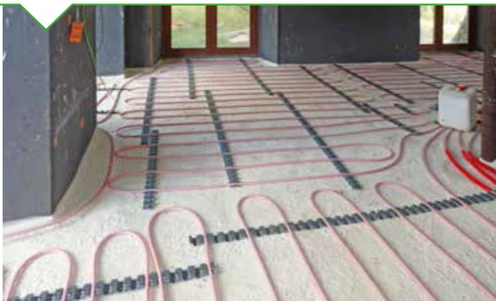
*Le sol est isolé et équipé d'un plancher chauffant.*
