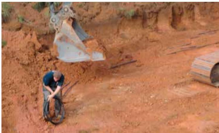
*Les capteurs géosolaires de la géothermie sont enterrés dans le terrain.*
