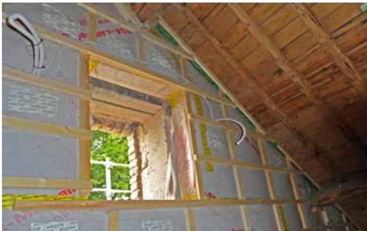
*Les murs intérieurs sont isolés en ouate de cellulose insufflée.
