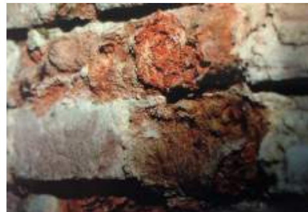
Boursouflure matière hygroscopique : calcite -> gypse
