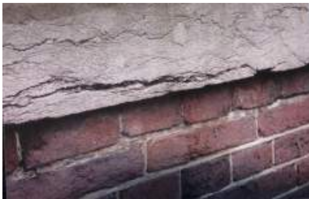
Stylolithes = décompression (mat. organique pyrite, argile...)
