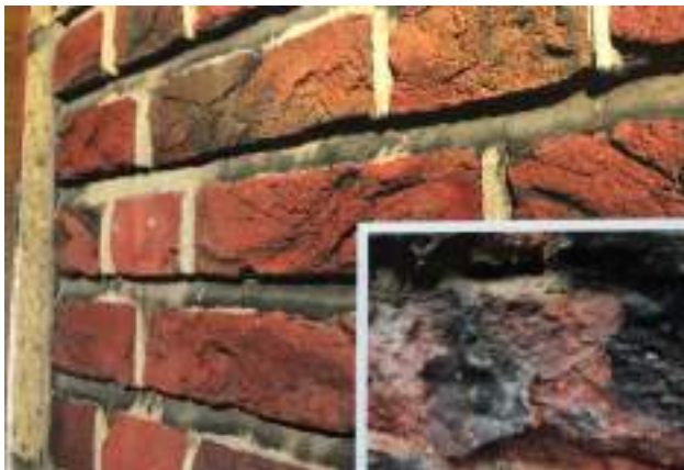
Croûte matière hygroscopique : calcite -> gypse
