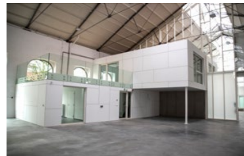
◀ La rénovation a permis la création d'un espace ouvert multifonctions destiné aux entreprises.
