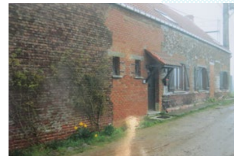
▲ façade avant travaux.
