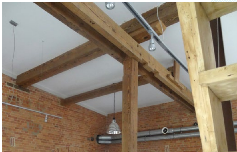
▲ Les poutres en bois ont servi de coffrage aux dalles en béton et sont visibles sur chaque plafond.
