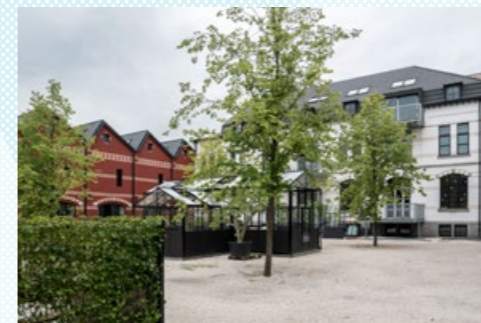
▲ Toutes les toitures ont été isolées avec de la ouate de cellulose sur une épaisseur de 30 cm.
