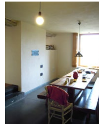
▲ Tous les murs ont été isolés à l'aide de panneaux de liège, plafonnés avec de l'argile.
