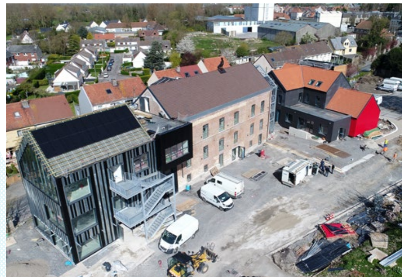
▲ L'adaptation des espaces historiques à des usages tertiaires s'est déroulé via un chantier d'importance.
