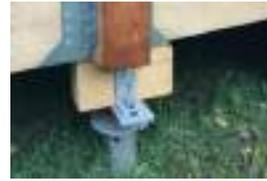
Plancher connecté aux fondations via équerre et boulons
